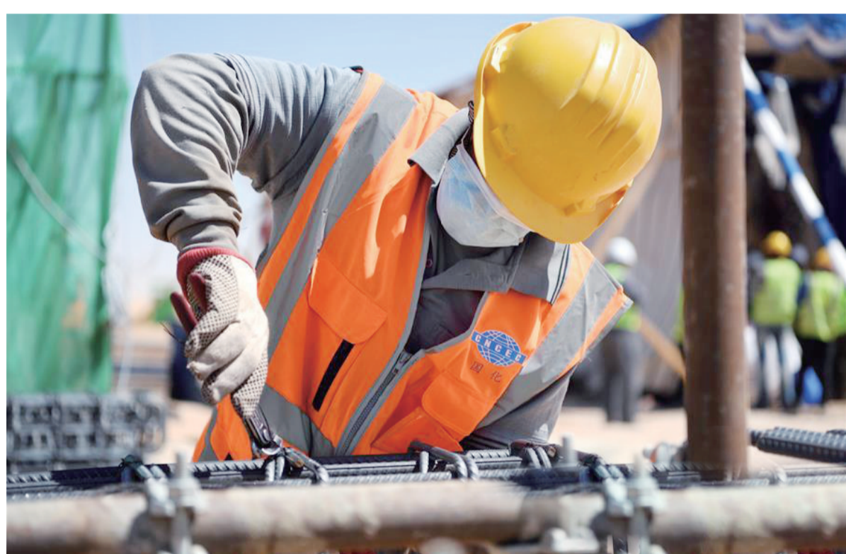
4月10日,在埃及南部阿斯旺省本班光伏产业园,工人在首个由中国企业承建并参与融资的光伏发电项目施工现场工作。
