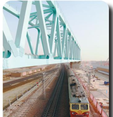
2010年12月7日,位于集包铁路第三双线上的重点控制性工程——古城湾特大桥转体施工在内蒙古包头市境内顺利完成。
