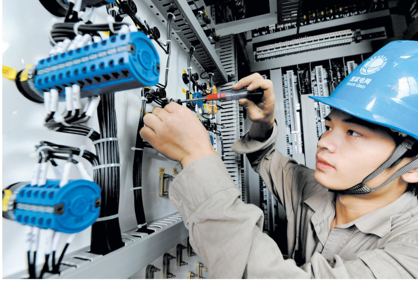
10月6日,福建第二电力建设公司职工在福州先农220千伏变电站安装开关柜。
