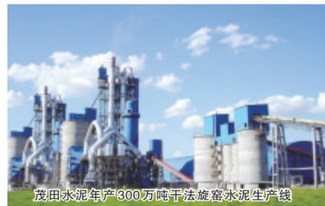
茂田水泥年产300万吨干法旋窑水泥生产线
