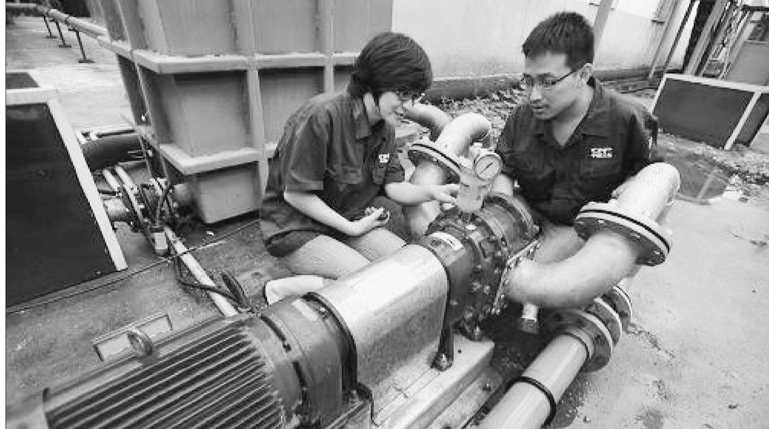
日前,国内首套城市道路真空高速排水系统已由中国北车研制成功,该系统排水效率比传统排水泵成倍提升,而且只需要对立交桥下道路进行“微创手术”,就能立竿见影地提升桥区应对强降雨的能力。图为两名技术人员在查看道路真空高速排水系统中的真空机组。(摄影/刘长龙)
