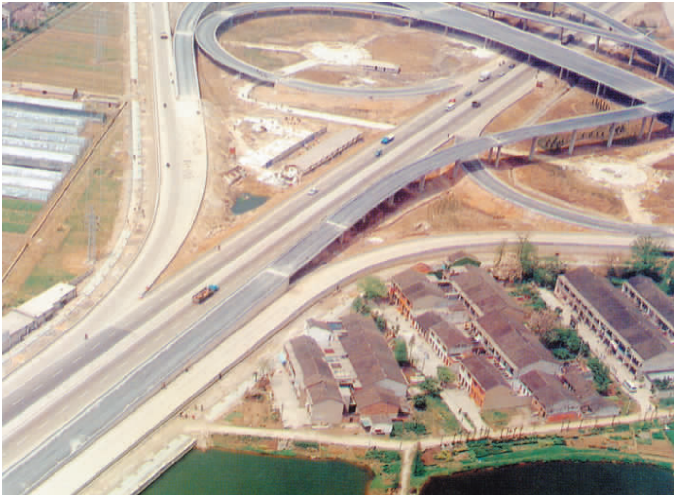
广南立交主桥
