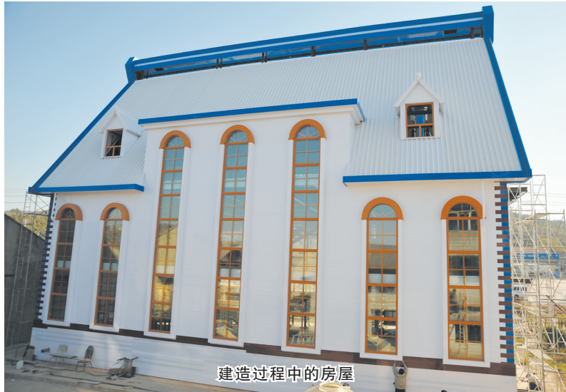
建造过程中的房屋
