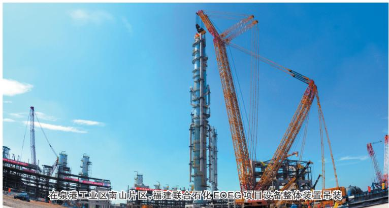
在泉港工业区南山片区,福建联合石化EOEG项目设备整体装置吊装
