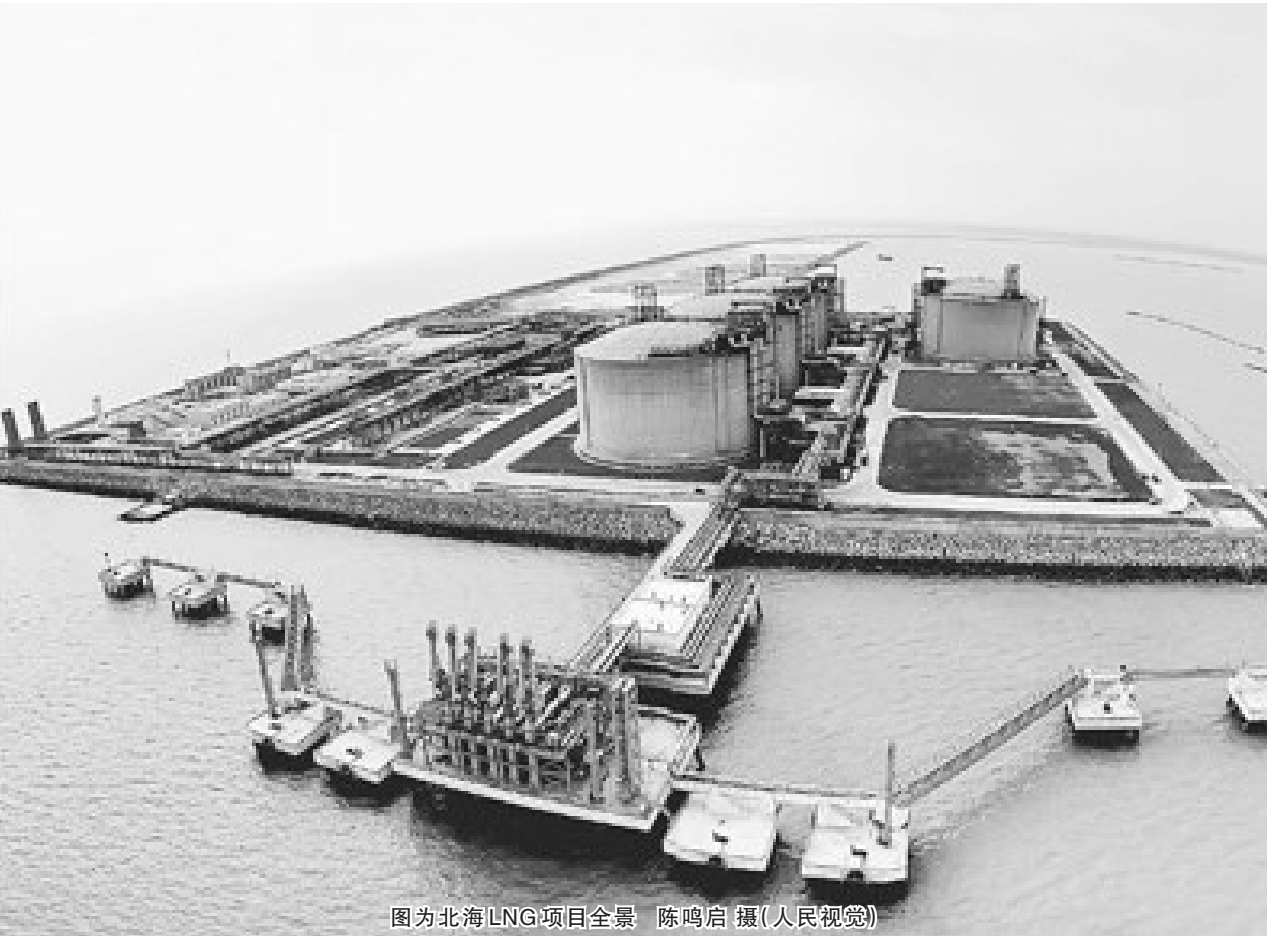
图为北海LNG项目全景 陈鸣启 摄(人民视觉)
