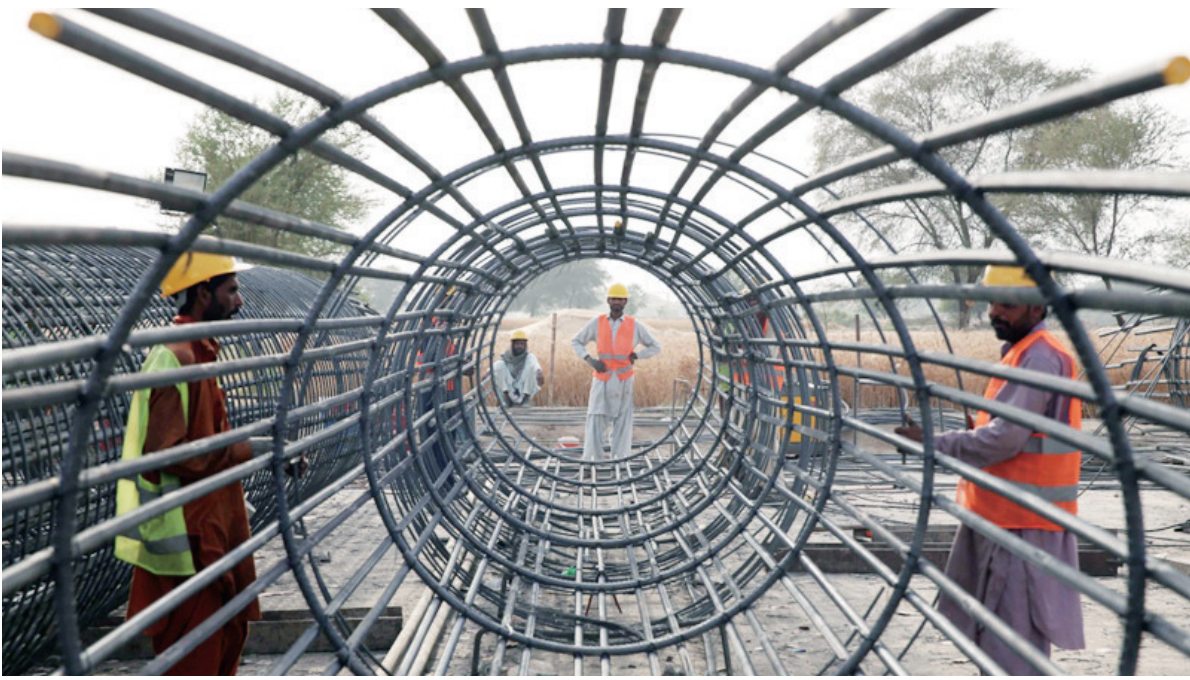
4月21日 在巴基斯坦木尔坦附近 巴基斯坦工人在白沙瓦至卡拉奇高速公路(木尔坦至苏库尔段)的一处工地施工。由中国建筑股份有限公司承建的白沙瓦至卡拉奇高速公路(木尔坦至苏库尔段)全长392公里 是中巴经济走廊最大交通基础设施项目。 新华社记者 刘天 摄
