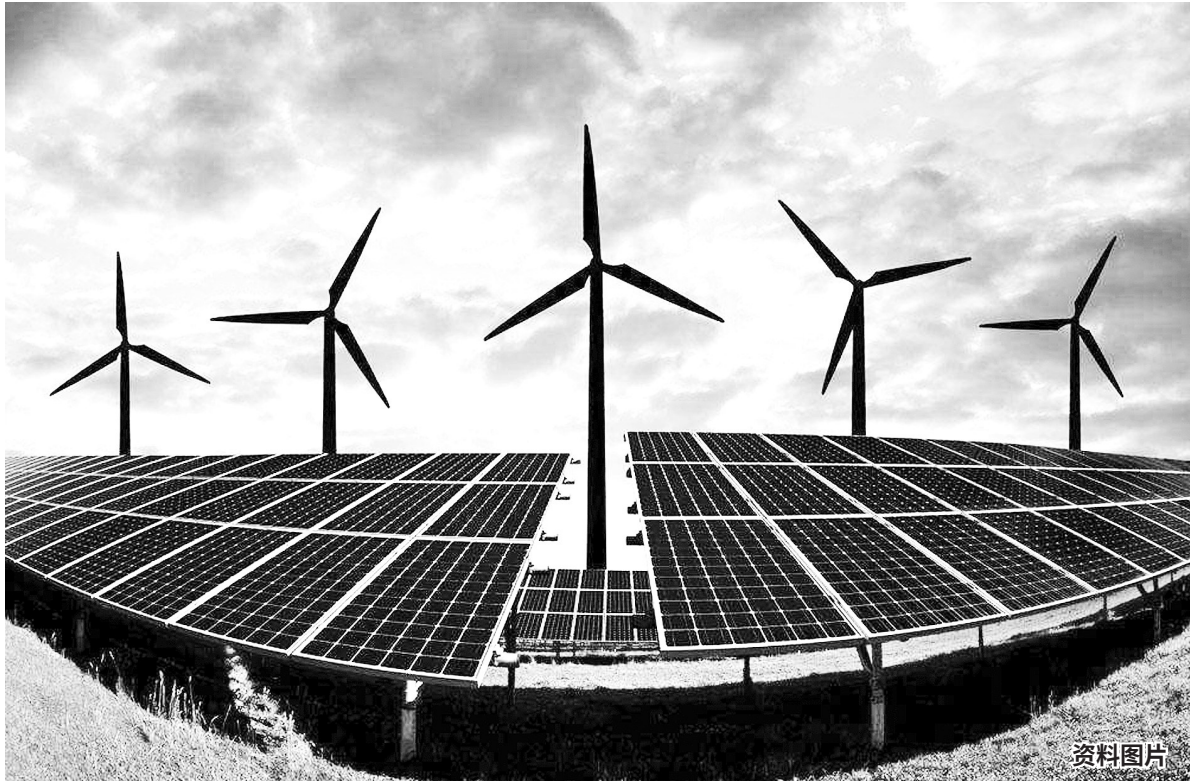
图为太阳能和风能发电装置,太阳能和风能都是新能源。
