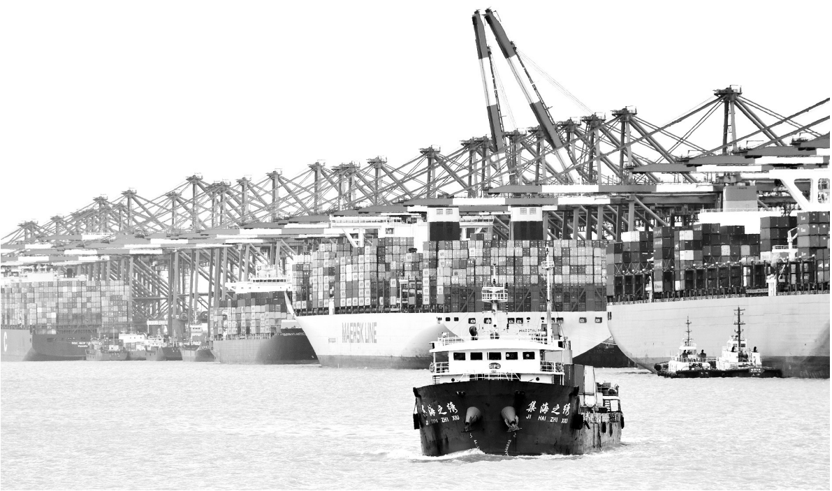
上海洋山深水港四期工程正在建设中,这是目前全球建设规模最大的自动化集装箱码头。洋山港区位于浙江省嵊泗县境内,可供开发的深水岸线4900米,是上海国际航运中心的深水港区。洋山港四期码头岸线为2350米,陆地作业面积2.23平方公里,有7个泊位,其目标吞吐能力初期为400万标准箱,远期达630万标准箱。
