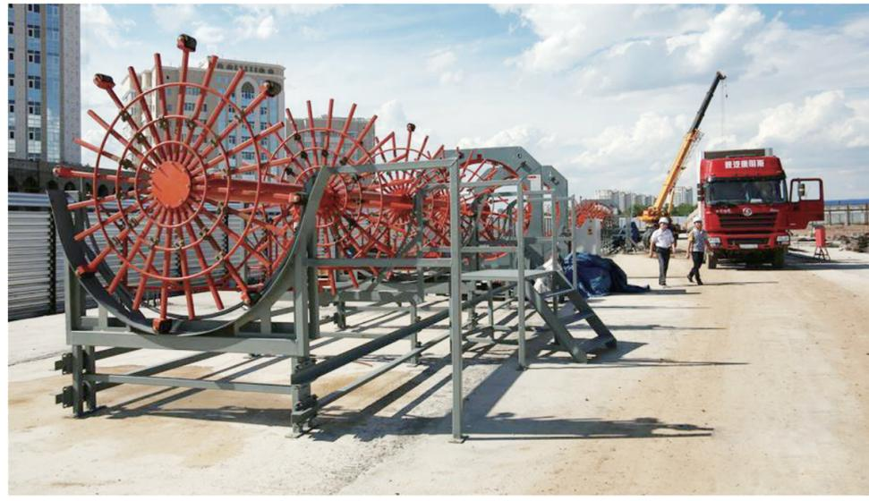
图为在哈萨克斯坦阿斯塔纳轻轨项目工地上，用于生产钢筋的滚笼机安装工作即将完成。建设中的阿斯塔纳轻轨是哈萨克斯坦首条城市轻轨。项目采用中国规范设计施工并由中国企业承建。目前，中建六局、中铁二局和北京城建正在不同标段开展建设。新华社发 奥斯帕诺夫 摄
