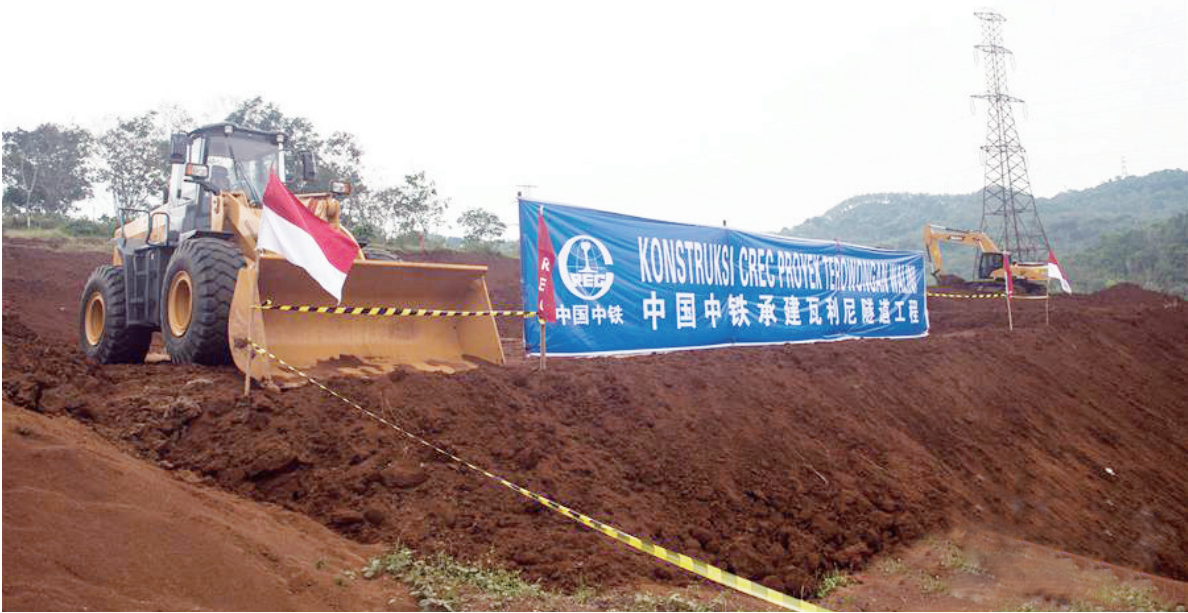
图为印度尼西亚雅万高铁瓦利尼隧道施工现场。该隧道由中国中铁股份有限公司承建。雅万高铁工程全长142公里,连接印尼首都雅加达和第四大城市万隆,计划3年建成通车。
