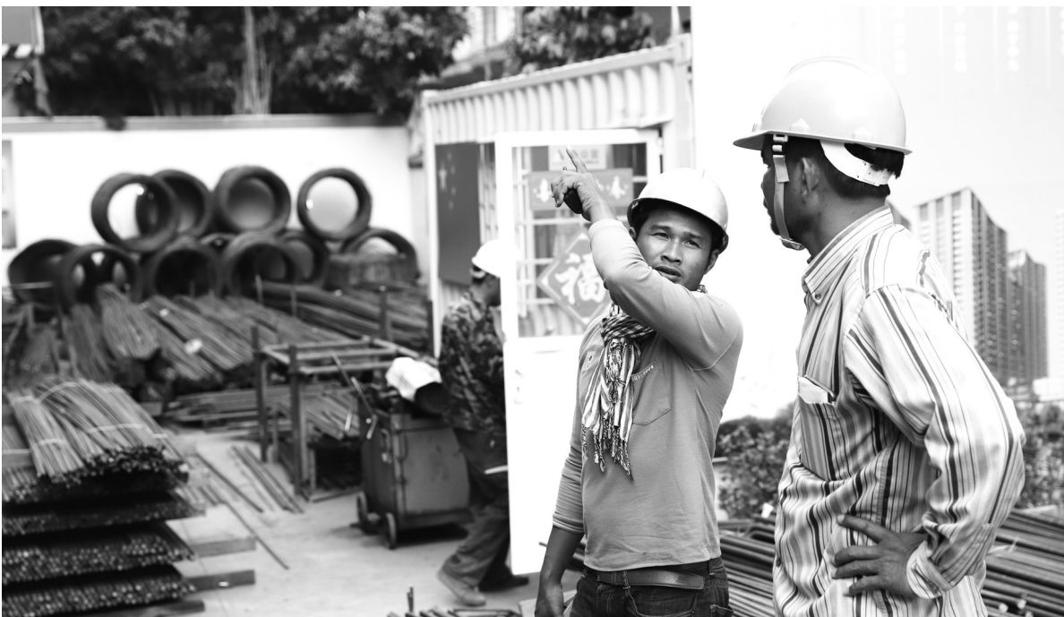
江苏南通建筑企业积极响应国家“一带一路”倡议,深入推进“走出去”战略,参与“一带一路”沿线国家项目建设,推动沿线国家基础设施建设,为当地社会、经济发展作出贡献。图为南通达欣建设集团在柬埔寨金边建设工地上的柬埔寨籍员工。
