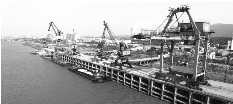
图为安徽铜陵港长江外贸码头上,港口机械正在装卸货物。
