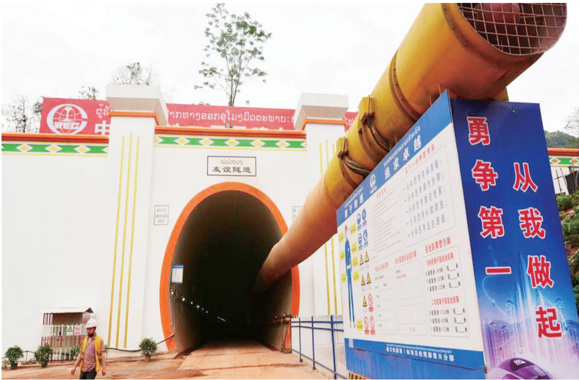
友谊隧道是一条连接中国和老挝的跨境隧道,全长约9.6公里,其中中国境内约7.1公里,老挝境内约2.5公里,目前隧道建设正在顺利进行。 图为3月26日在老挝磨丁拍摄的中老铁路友谊隧道施工现场。 新华社发 刘艾伦 摄
