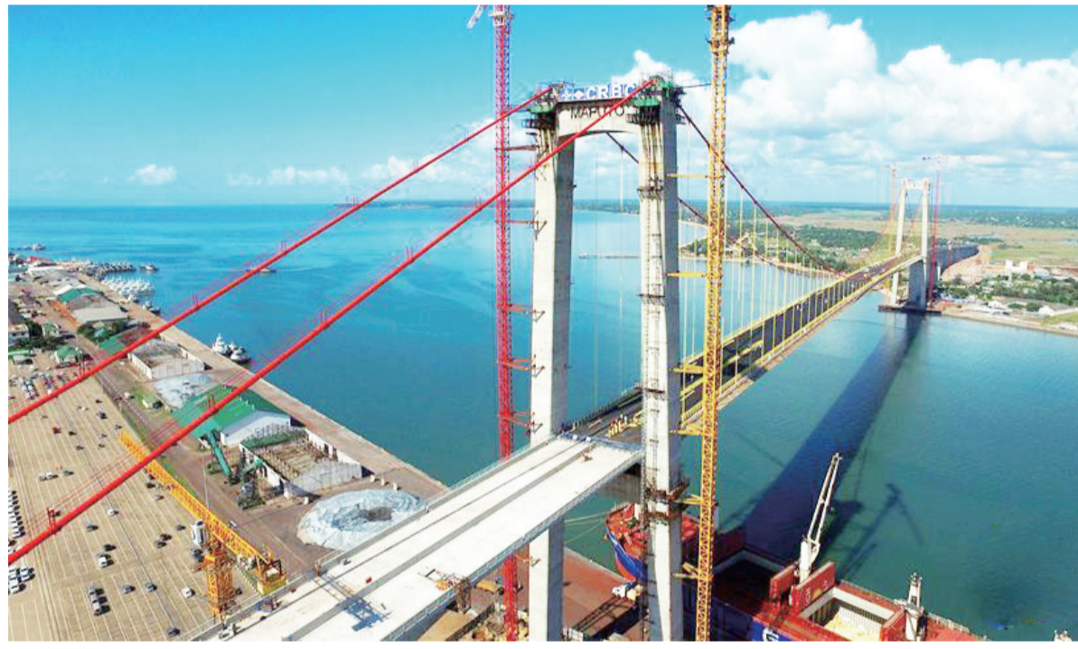
由中国路桥公司承建的中国在莫桑比克最大基建项目——马普托跨海大桥及其连接线工程预计将于2018年6月正式通车。这座总长3公里多的跨海大桥建成后,将以680米长的主跨,成为非洲主跨径最大的悬索桥,并极大便利马普托和对岸卡滕贝之间的交通。
