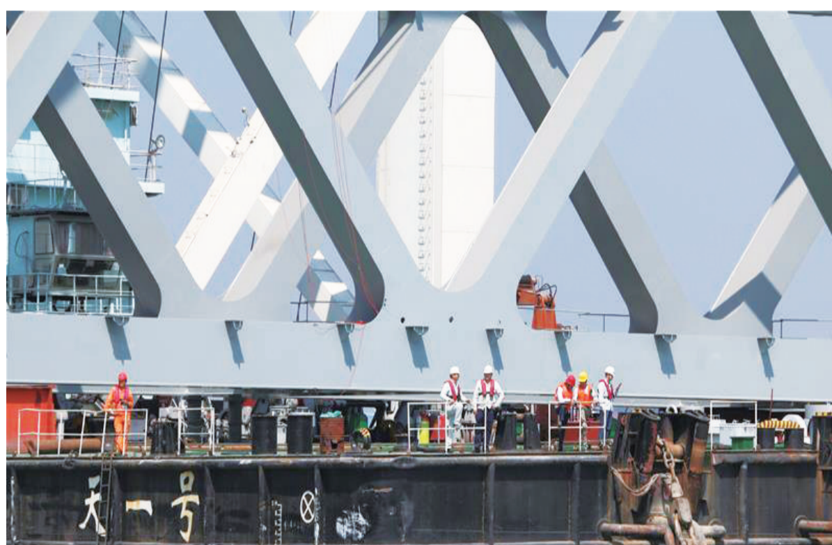
由中铁大桥局集团有限公司承建的孟加拉帕德玛大桥项目取得重要进展,万吨级中心架梁起重船“天一号”成功将重达3200吨的第五跨钢架梁设到桥墩上。帕德玛大桥的建成将结束孟加拉国南部21个区与首都达卡之间居民摆渡往来的历史。帕德玛大桥将是连接中国及泛亚铁路的重要通道之一。图为6月29日,在孟加拉国帕德玛河上,施工人员在万吨级中心架梁起重船“天一号”上作业。新华社发
