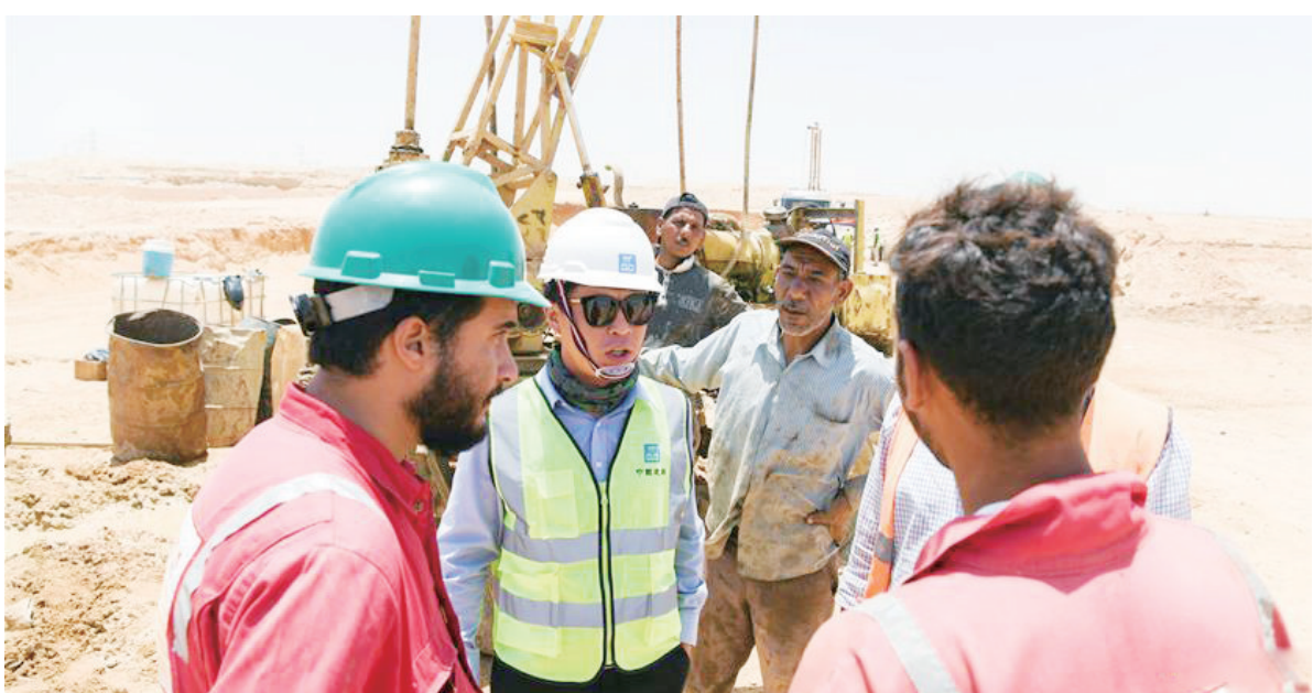
埃及政府自2015年开始在开罗以东沙漠地带规划一座新行政首都,计划占地700平方公里,转移开罗500万人口以及政府机关和外国使馆。中国建筑股份有限公司承担的新行政首都中央商务区项目位于新行政首都一期核心区。图为中国建筑股份有限公司的现场技术人员和埃及同事在埃及开罗以东新行政首都的“地标塔”建设现场工作。新华社记者 郭惠惠 摄
