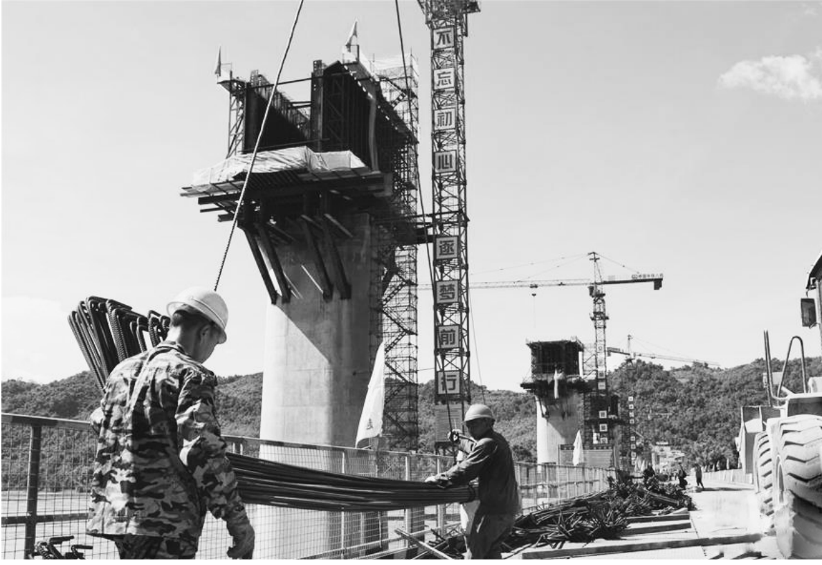
据中国中铁八局中老铁路第三标段项目部负责人介绍,该项目部承建的中老铁路琅勃拉邦湄公河特大桥主桥23号墩0号块近日顺利完成浇筑。图为在老挝琅勃拉邦拍摄的中老铁路琅勃拉邦湄公河特大桥主桥施工现场。
