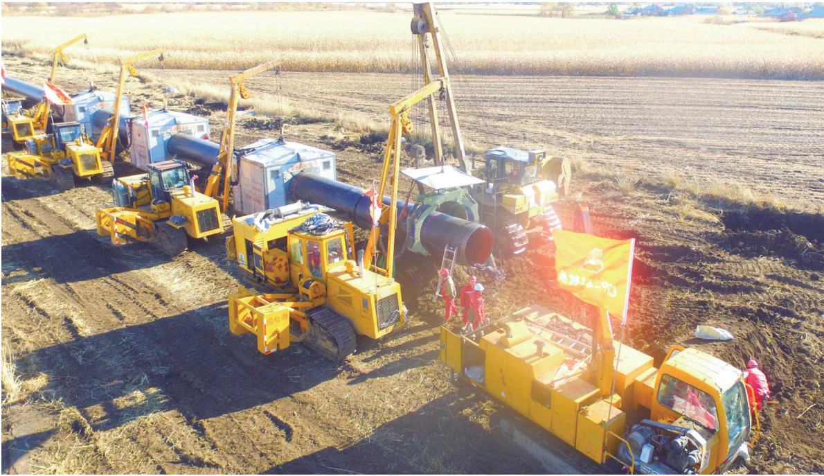
10月7日,由中国石油管道局四公司承建的中俄东线天然气管道工程一标段项目突破60公里,这意味着中俄东线天然气管道工程进入关键提速期。 中俄东线天然气管道是我国目前口径最大、压力最高的长距离天然气输送管道,是继中亚、中缅向中国供气的第三条跨国天然气管输管道,也是全球天然气合作的重大战略性项目。 中俄东线工程投产后,将进一步改善中国的能源结构,带动中俄两国沿线的经济社会发展,促进两国能源战略多元化和保障两国能源安全,对全球能源合作格局将产生积极影响。
