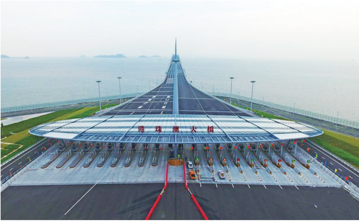
全球最长跨海大桥——总长约55公里的港珠澳大桥10月24日正式通车运营,有助于粤港澳大湾区形成1小时生活圈。港珠澳大桥跨越伶仃洋,东接香港特别行政区,西接广东省珠海市和澳门特别行政区,是在“一国两制”框架下、粤港澳三地首次合作建设的超大型跨海交通工程。图为无人机拍摄的港珠澳大桥收费广场。
