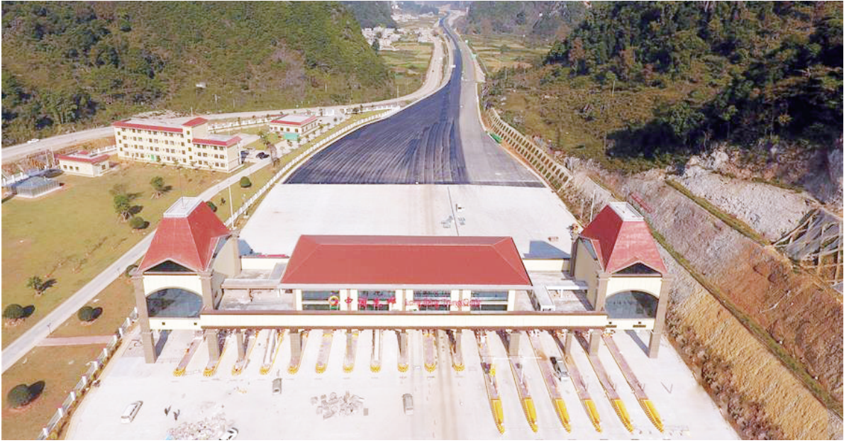
目前,广西中越边境靖西至龙邦高速公路建设工程已进入收尾阶段,预计今年年底通车。这段高速公路建成通车后,将完善广西出境高速公路网,为我国西南地区通往东南亚各国打开一条新的陆路通道。新华社记者 张善臣 摄
