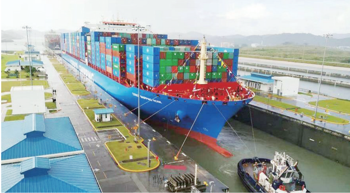
巴拿马运河是连接太平洋与大西洋的黄金水道,在国际贸易中发挥着重要作用。目前,中国是巴拿马运河第二大用户。图为满载集装箱的中国远洋海运集团“玫瑰轮”正在巴拿马运河新船闸停靠等待过闸。 (图片来源:央视新闻客户端)
