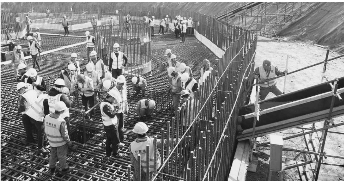
2月25日,由中国建筑股份有限公司承建的埃及新首都中央商务区的标志塔主楼1.85万立方米超大型混凝土基础底板开盘浇筑。图为工人在施工。
