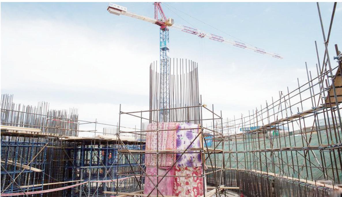
初春时节,在埃及首都开罗以东50公里的新行政首都中央商务区建设工地上,重型卡车、推土机、挖掘机不停穿梭,中国建筑股份有限公司的中方员工与埃及合作伙伴的施工作业正在紧锣密鼓地进行。图为建设项目现场。
