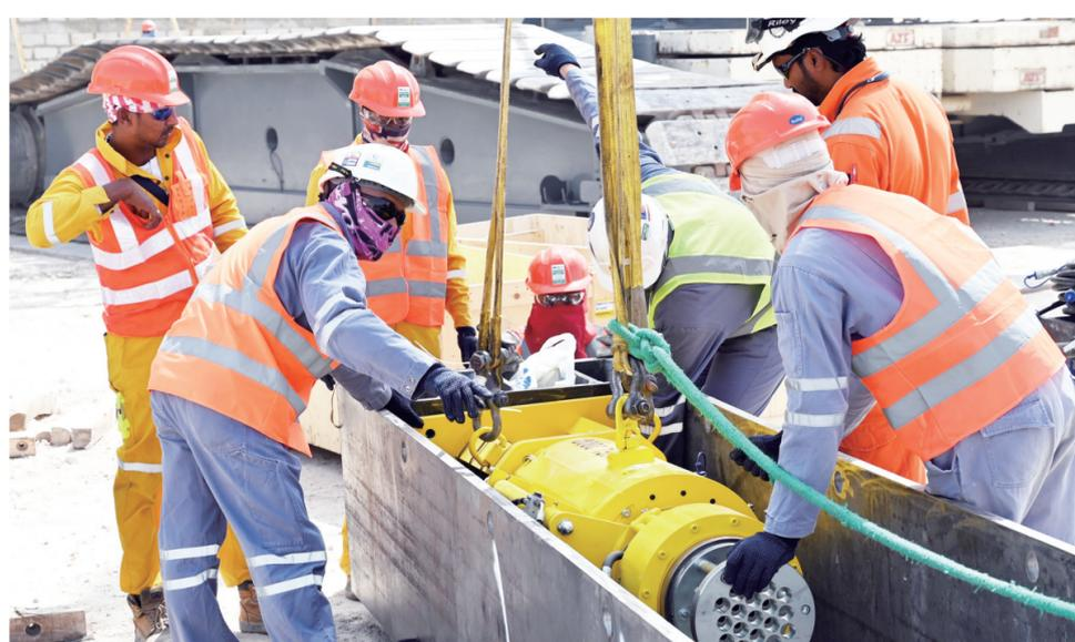
日前,中国铁建承建的2022年卡塔尔世界杯赛体育场卢赛尔体育场项目第一根主钢结构V型柱吊装顺利完成。2016年11月28日,中国铁建与卡塔尔HBK公司组成的联合体中标了卢赛尔体育场建设项目。这是中国公司首次以总承包商身份承建世界杯体育场。卢赛尔体育场将担当2022年卡塔尔世界杯开幕式、揭幕赛、决赛、闭幕式等四项重任,建成后将成为卡塔尔的国际化地标性建筑。图为工人们在进行穿心千斤顶安装。
