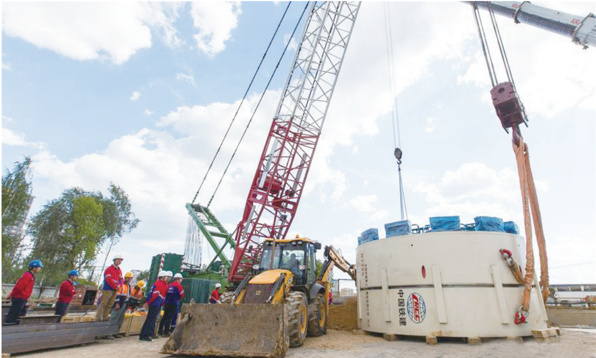
两年前,中国铁建股份有限公司(中国铁建)赢得竞标,承建莫斯科地铁第三换乘环线3个车站主体结构及部分隧道工程。图为在俄罗斯首都莫斯科,工人准备进行吊装作业。 新华社记者 白雪骐 摄
