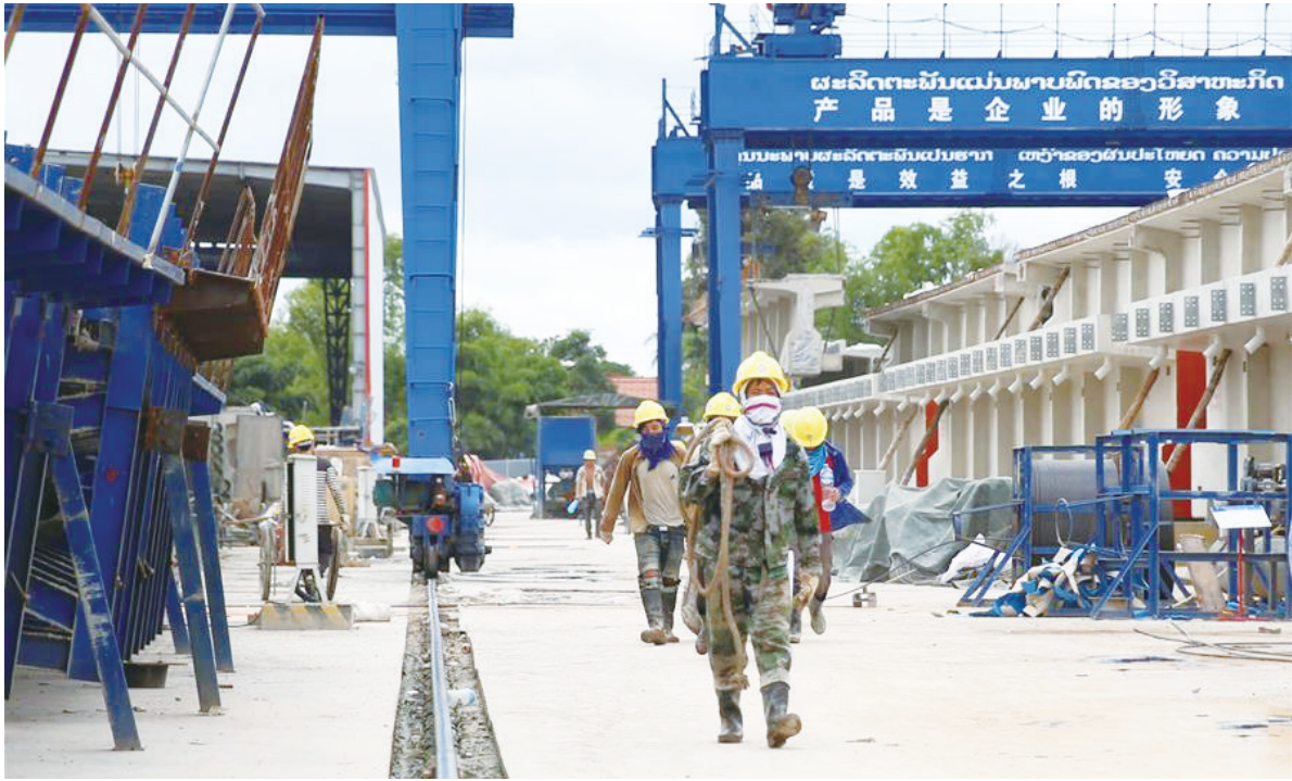
中老铁路北起两国边境,南抵万象,是以中方为主投资建设、中老共同运营并与中国铁路网直接连通的境外铁路项目。图为在老挝万象中老铁路项目施工现场,来自老挝南部阿速坡省的男子在工作。新华社发 熊天泽 摄
