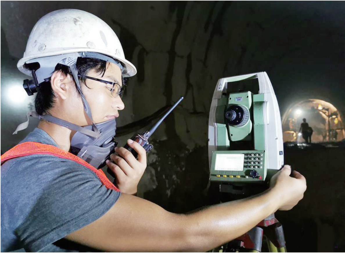
中铁五局承建的中老铁路空琅村隧道长9020米,为了有效降低洞内温度,项目经理部专门购置了制冰机,每隔6小时将大约5吨重的冰块运到隧道掌子面施工现场降温。图为在老挝空琅村,中铁五局中老铁路项目部的工作人员在隧道工地工作。
