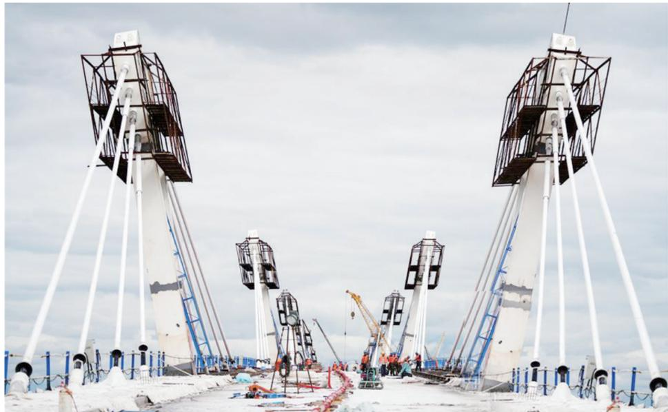
目前中俄合建的首座跨境公路大桥——黑河到布拉戈维申斯克黑龙江(阿穆尔河)大桥进入桥面铺装施工阶段。大桥全长1284米,建成后将实现中俄地方城市之间互联互通。图为工人在大桥上进行桥面铺装施工作业。
