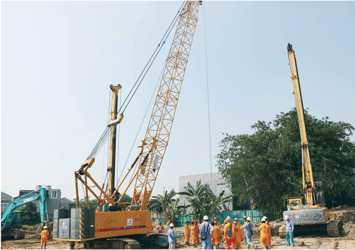
8月31日,由中资企业为主投资开发、中国能建葛洲坝集团承建的印尼首个大学主题公寓——双弘公寓项目开工奠基并开盘,这是中国能建葛洲坝集团在印尼承接的首个房建工程项目。双弘公寓项目位于印尼万丹省唐格朗县,距离雅加达市中心仅24公里,总占地约29681平方米,总建筑面积约436000平方米,由9栋公寓楼组成,可以提供上万套公寓住宿。图为建设方在现场施工。
