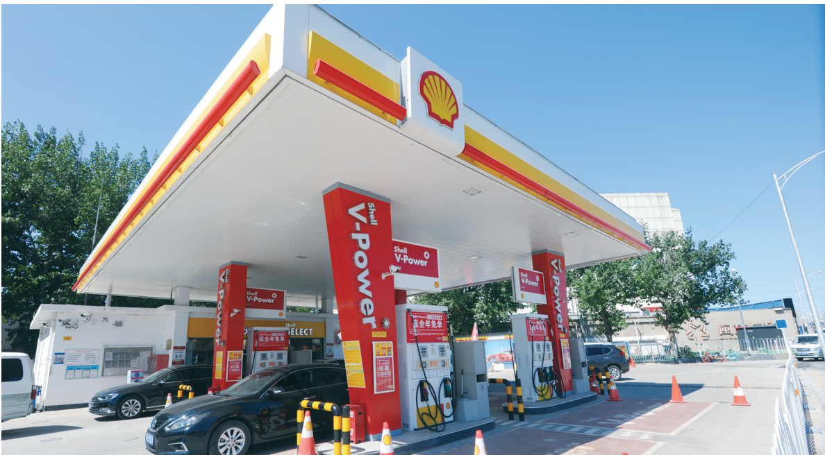
世界500强企业荷兰壳牌集团的北京办事处于1980年成立,随后的30多年里,壳牌集团在华业务线不断延长,涵盖了石油、天然气、沥青、润滑油、环保、能源咨询等很多方面,其中壳牌加油站在中国很多地区都有分布。图为位于北京市朝阳区的壳牌加油站。
