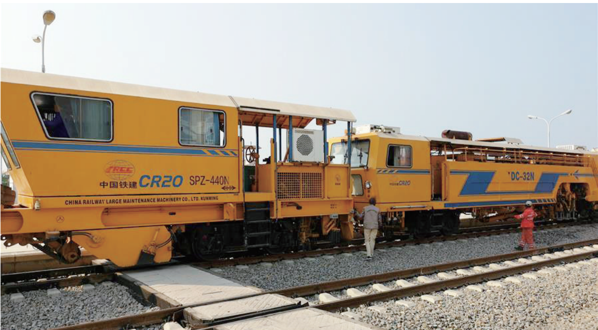
安哥拉本格拉铁路横贯安哥拉全境,全长 1344 公里,由中铁二十局集团公司总承包,全部采用中国铁路建设标准。图为在本格拉铁路洛比托站拍摄的大型维护机械。 新华社发 柳志 摄
