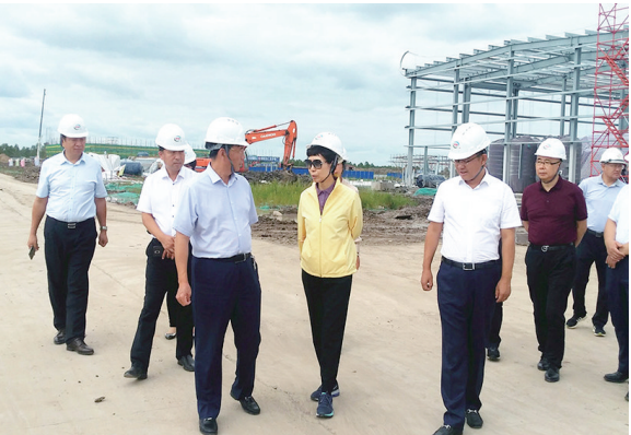
高燕会长调研林甸县伊利集团液态奶基地二期工程建设
