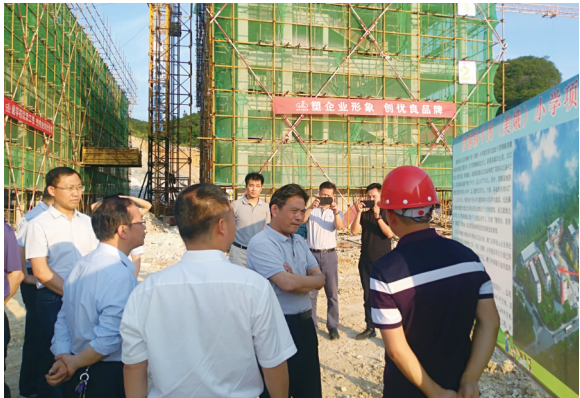
张慎峰副会长在从江县调研澳门投资帮扶的千团小学综合楼建设
