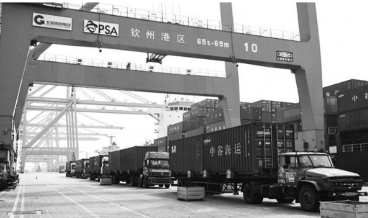
图为正在进行装卸作业的钦州港集装箱码头。 新华社记者 曹祎铭 摄
