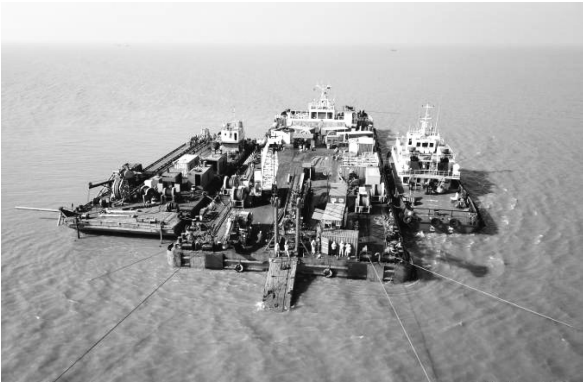
中国石油管道局工程有限公司透露，近日，由管道局承建的孟加拉国单点系泊项目控制性工程6条登陆定向钻穿越全面告捷，该工程连续刷新中国管道陆海定向钻穿越纪录，获得业主方及国际专业监理的称赞。（宋敏涛 何志丹）
