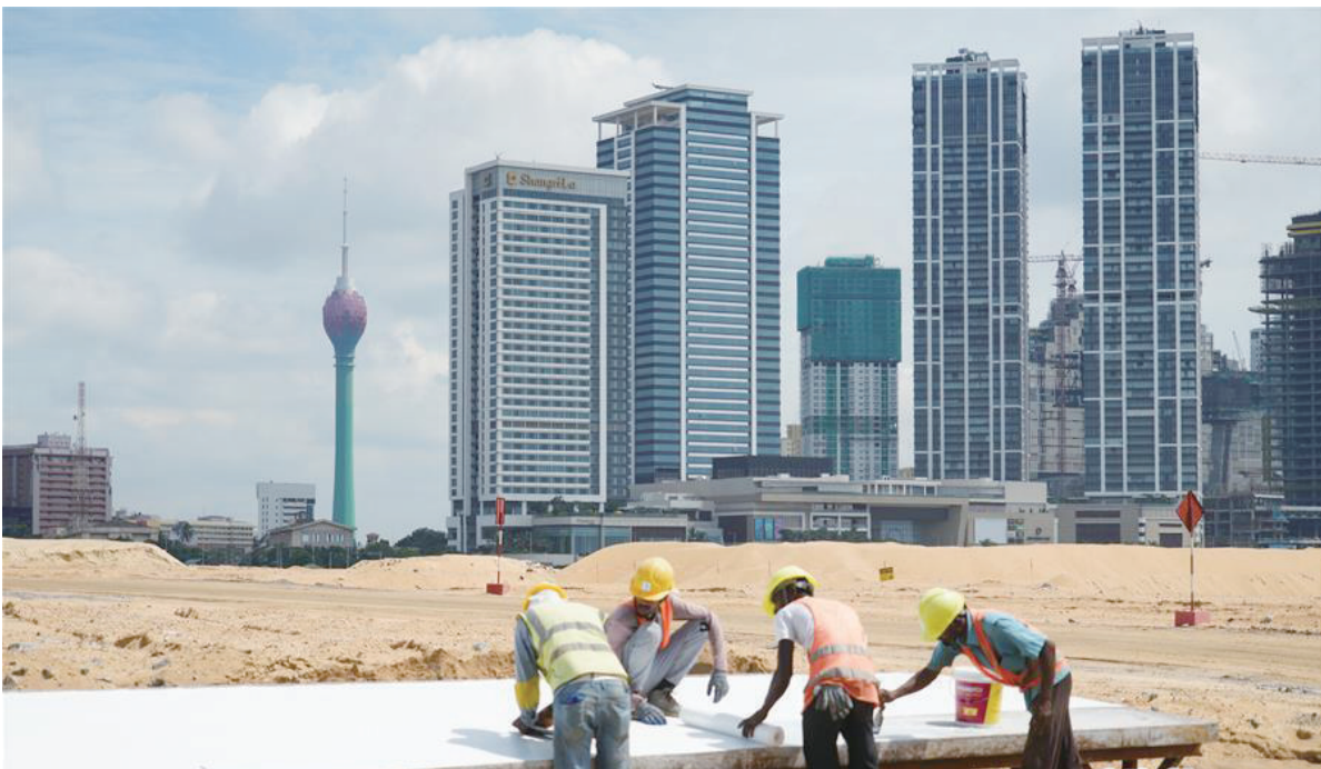
12月7日傍晚,一场盛大的庆典在科伦坡港口城举行,纪念港口城正式成为斯里兰卡首都科伦坡永久土地。2019年1月16日,伴随着三声长长的鸣笛声,最后一条停留在科伦坡港口城承担填海吹沙任务的大型挖泥船停止管吹,科伦坡港口城269公顷吹填土地全部形成。斯里兰卡大都市与西部发展部长拉纳瓦卡说,科伦坡港口城是“斯里兰卡有史以来最壮观的发展项目”。
