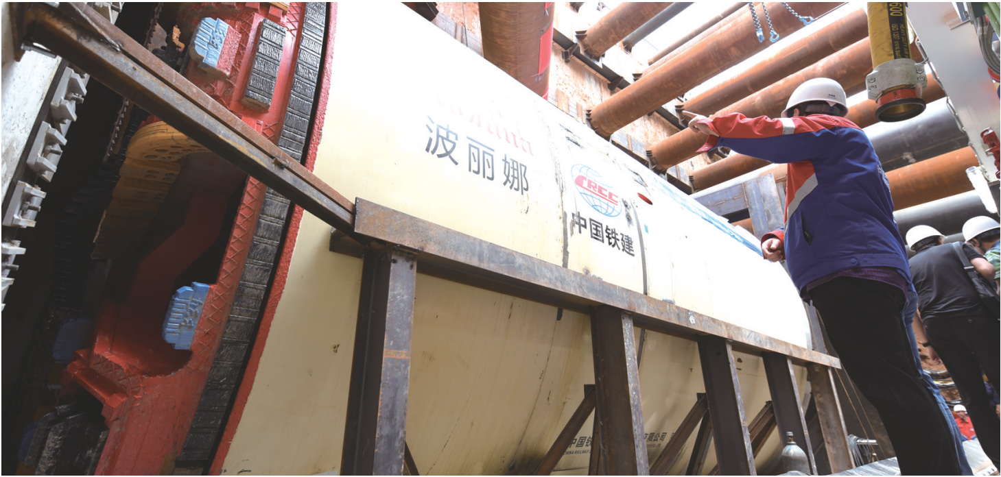
“波丽娜”号盾构机在施工现场 吴少主 摄
