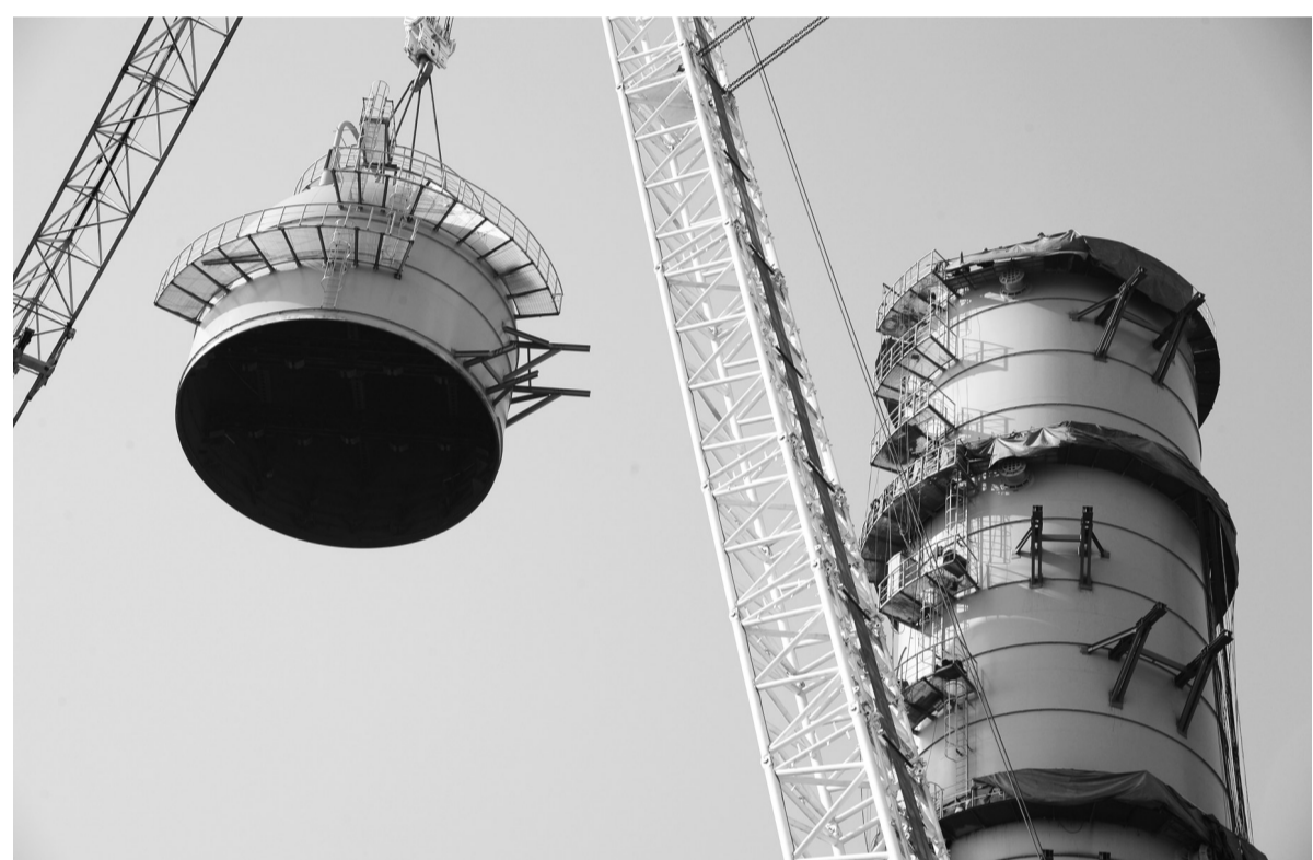
12月27日,山东省青岛西海岸新区董家口循环经济园区金能90万吨/年丙烷脱氢项目现场,中建安装集团中建五洲公司对2#丙烷脱氢装置分离塔封头进行吊装。上午11时许,随着重226吨的封头吊装结束,总重2600吨、高103米2#产品分离塔完美“合体”,标志着全球目前产能最大的丙烷脱氢装置项目组装完成。中新社发 钟鑫旺 摄
