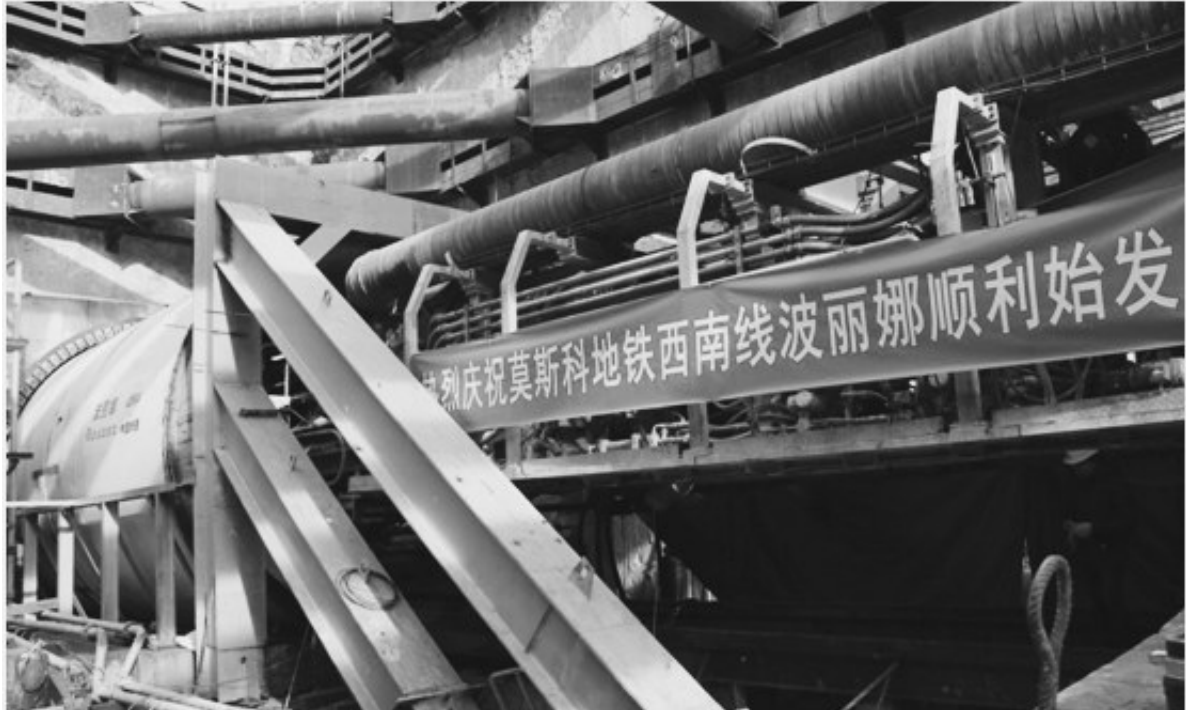
当地时间2月28日上午,中国铁建承建的莫斯科地铁西南线项目“波丽娜”号盾构机始发,这是该项目投入运行的第二台盾构机,中国铁建国际集团在做好疫情防控的同时,再次取得生产突破。 本报通讯员 彭云龙 李子 摄
