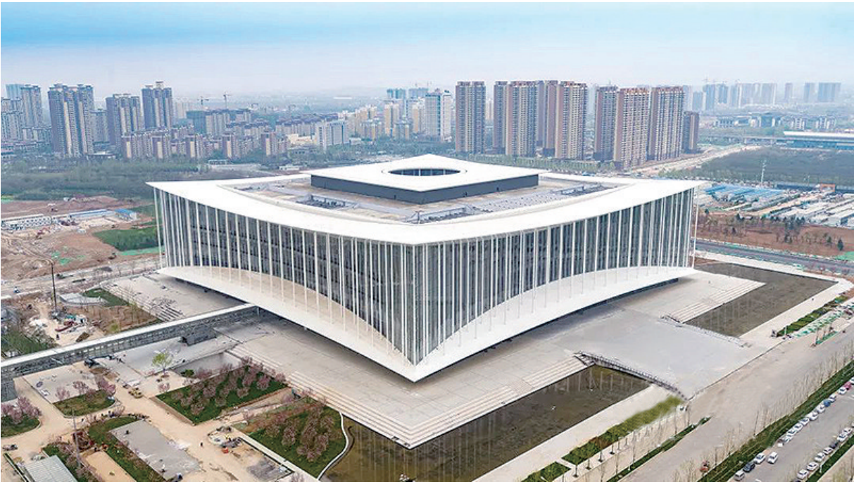
近日,坐落于西安浐灞生态区的西安国际会展中心项目通过竣工验收,进入试运营状态。预计5月后启动项目压力测试。(徐华梅)
