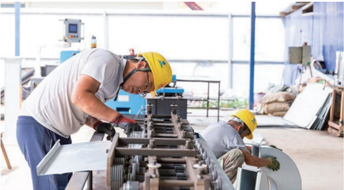
中国援助老挝玛霍索综合医院项目是中国为老挝援建的民生领域标志性项目。玛霍索综合医院总建筑面积约5.4万平方米,有600个床位,是中国目前对外援助中规模最大、床位最多、投资最大的医院项目,也是老挝规模最大、科室设置最全的综合性医院和最重要的医学教学基地。图为玛霍索医院项目建设现场。 新华社发 凯乔 摄
