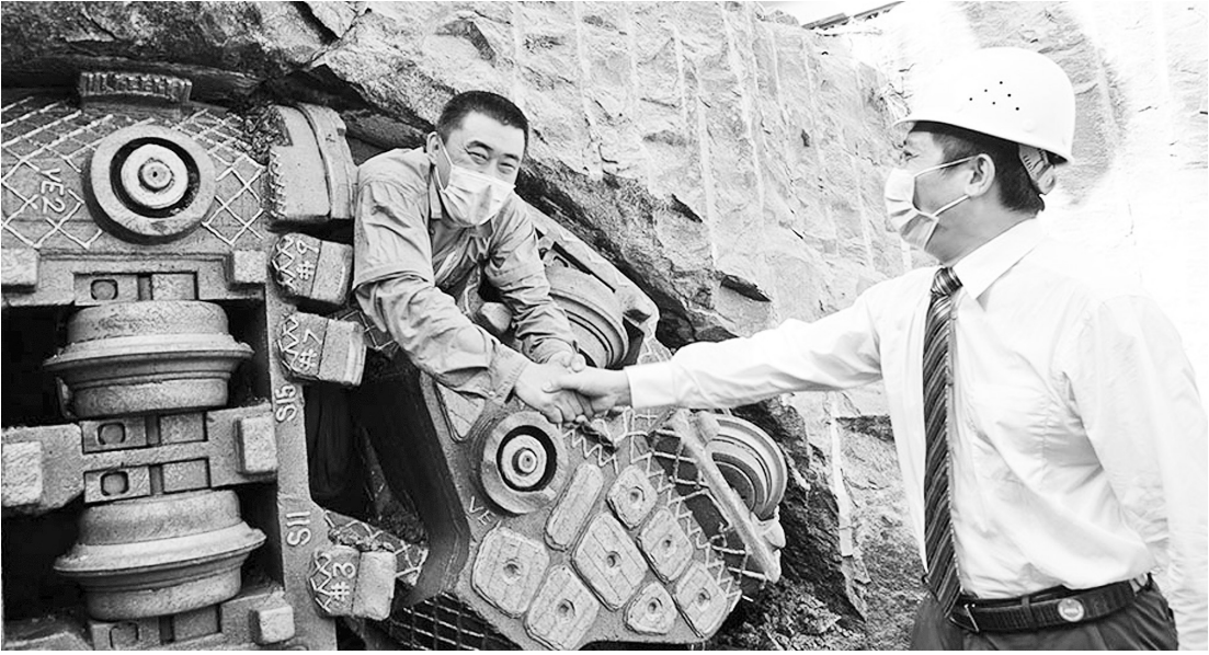
近日,斯里兰卡首都科伦坡北部地下排水项目新穆特瓦尔工程盾构隧道全线贯通后,中国企业项目经理与隧道另一侧的盾构机中方操作人员握手。 新华社记者 唐璐 摄
