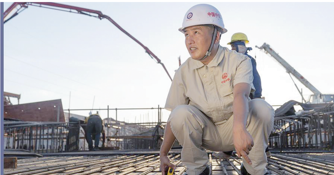
中老铁路是中国“一带一路”倡议与老挝“变陆锁国为陆联国”战略对接项目。在中老铁路工地上,中铁二局严格执行疫情防控制度和现场管控措施,努力将中老铁路建设成为“一带一路”标志性工程。 新华社发 潘龙柱 摄
