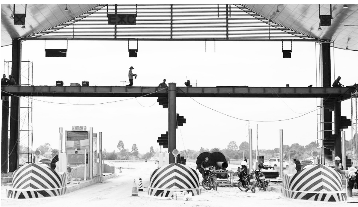
图为在老挝首都万象拍摄的建设中的万万高速公路万象入口。
