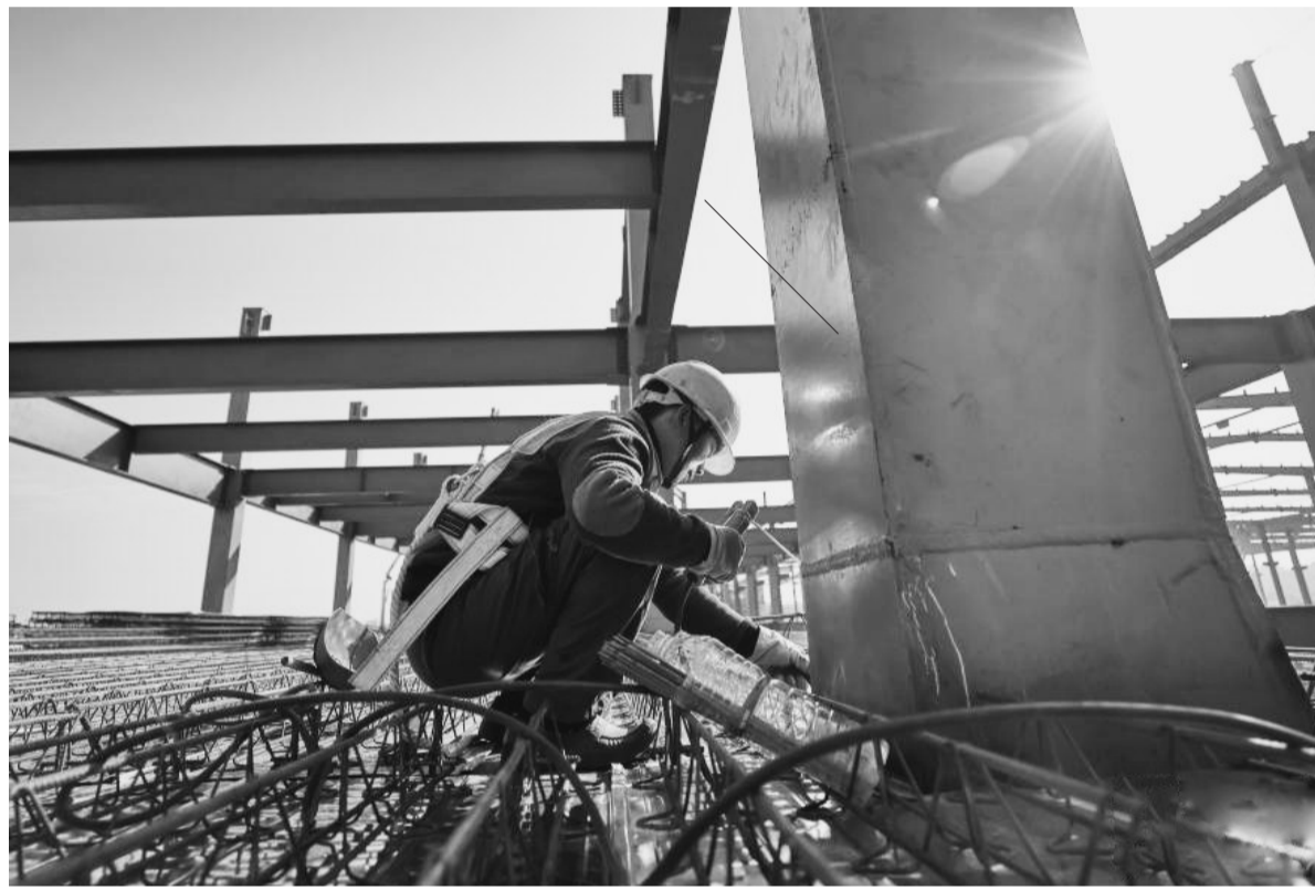
目前,海口美兰临空经济区航空发动机维修基地正在有序建设中。作为海南首个航空发动机维修基地,该项目位于海口空港综合保税区,包括发动机大修厂房、发动机试车厂房、车间供油站、综合服务楼等多个构筑物,计划2022年4月底竣工并投入使用。图为工人在项目现场作业。
