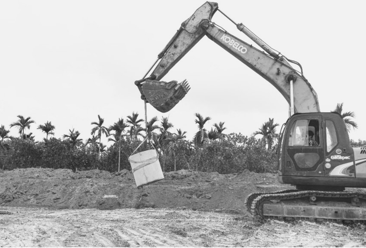
海南文昌国际航天城起步区路网工程项目完工后,将完善沿线道路交通系统和市政基础设施,推进海南自贸港重点园区——海南文昌国际航天城建设。目前,项目正在进行路基、桥梁和地下管网施工。图为工人操作机械在该项目工地施工。
