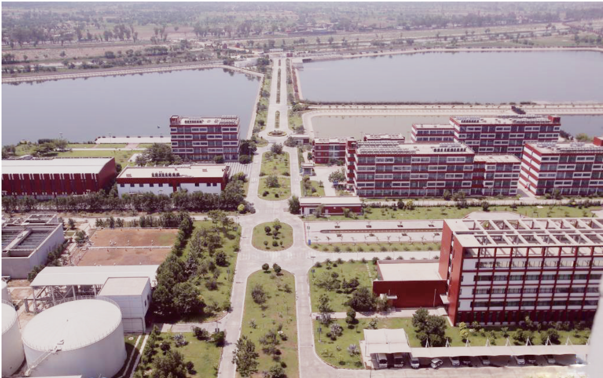
巴基斯坦东部旁遮普省的萨希瓦尔电站项目由中国华能山东发电有限公司和山东如意科技集团公司共同投资建设，是中巴经济走廊优先实施的重点能源项目。图为萨希瓦尔电站一景。
